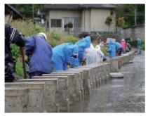
側溝の泥かきは、バールでの蓋の開閉を含めかなりの重労働で、作業は 10~20人で行います。蓋を開けた後は鋤簾(Եἰξηλ)、スコップなどを使って泥をかき出します。泥以外にも津波で流された新聞や衣類の他、瓦、ガラス、クギなど様々な危険物が溜まっているので、ケガをしないよう注意して取り出します。
